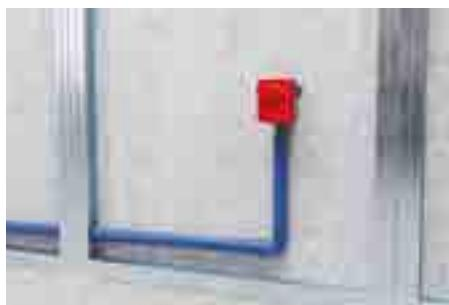
2.Collare il tubo di scarico allo scarico del sifone.
